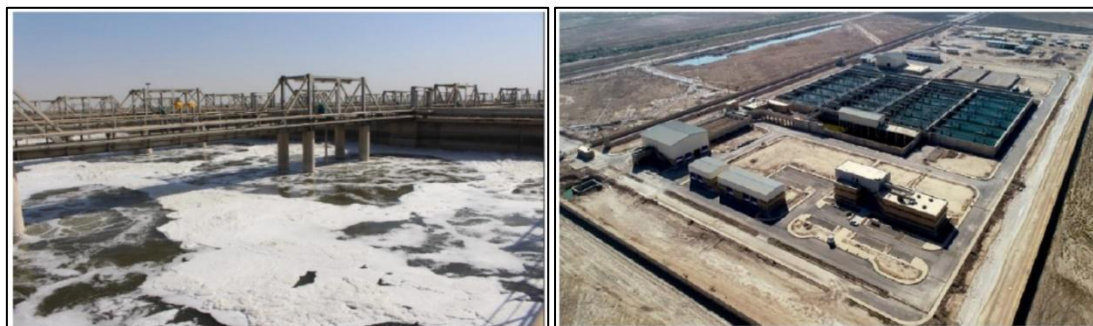
شکل ۱: نمایی از تصفیه‌خانه شرق اهواز
