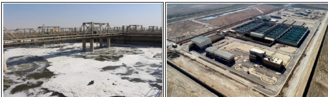
شکل ۱: نمایی از تصفیه‌خانه شرق اهواز
